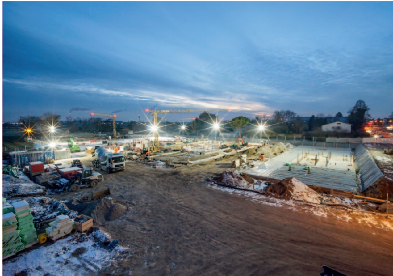
Nachtbaustelle des connect4: Die Montage im Scheinwerferlicht war für das ganze Team eine neue Erfahrung
