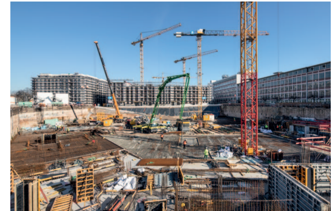
Im Vordergrund: Die gleichzeitige Erschließung mehrerer Bauabschnitte verlangte eine ausgeklügelte Planung – etwa was die Lagerung angelieferter Materialien angeht. So begannen die Arbeiten am WA7 zeitlich versetzt – denn zunächst musste dieses als Lagerplatz erhalten.
