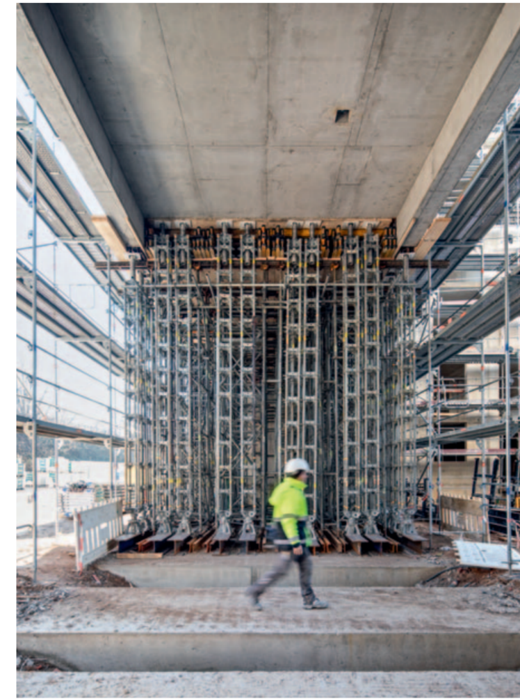
Die Brückenüberbauung muss 6 Stockwerke tragen können
