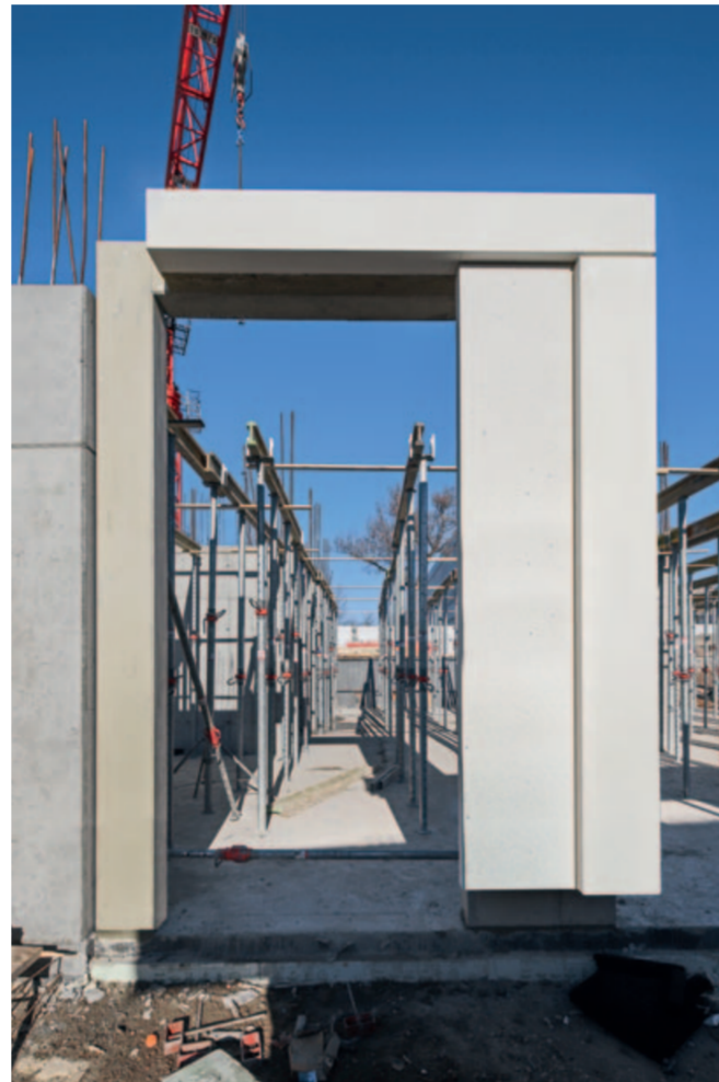
Es galt, eine weiße Fassade mit zurückgesetzten sandgestrahten Flächen zu planen, herzustellen und zu montieren
