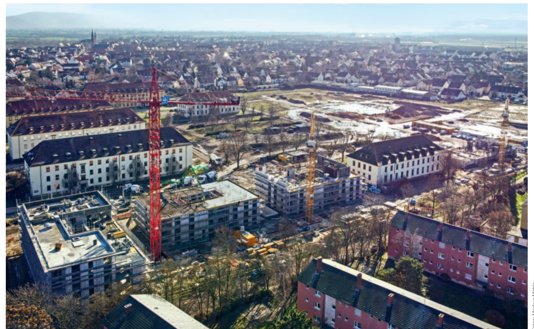
Die Neubauten fügen sich – später auch durch die Farbgestaltung – in eine bestehende Bebauung ein. Erhalten bleiben 5 Gebäude aus der 1930er-Jahren, die schon damals Teil einer Kaserne waren. Sie werden energetisch saniert und modern ausgebaut.
