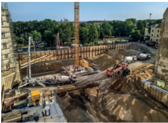
Der Aufbau des 58 m hohen Krans wurde in der Nachbarschaft mit einer Party gefeiert. Die Bauleitung war eingeladen.
