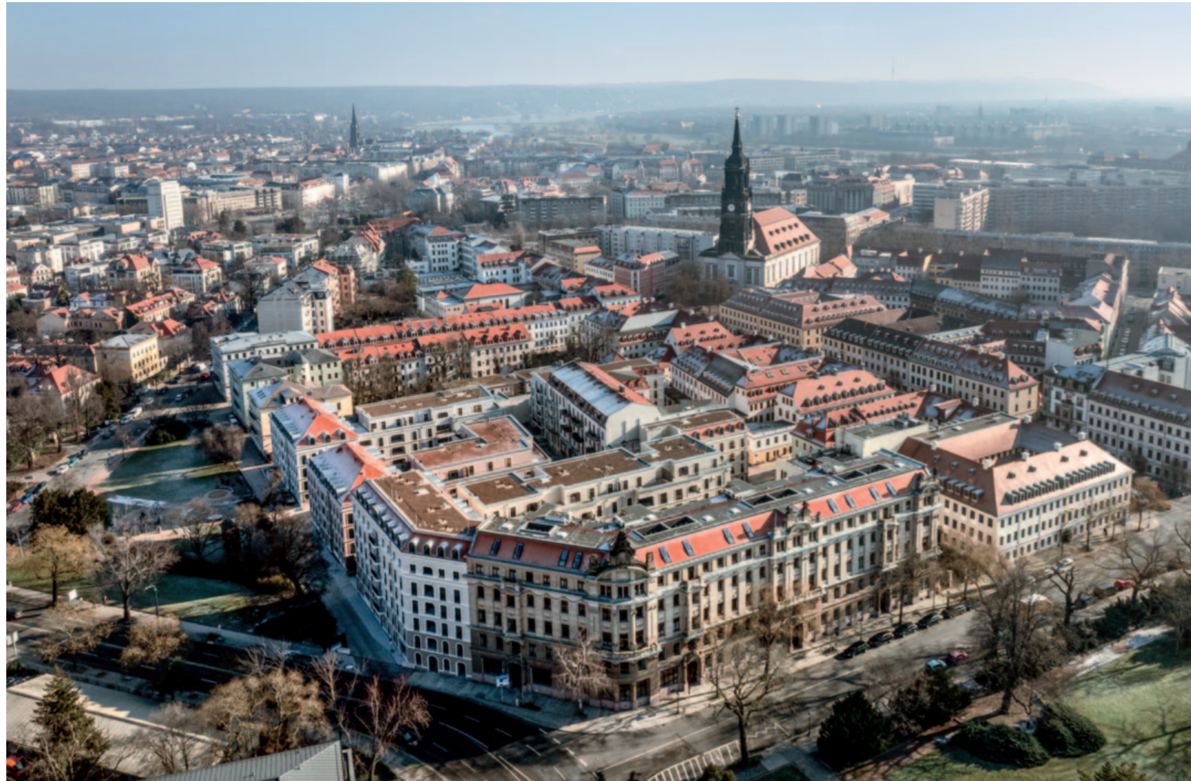
Die 9 Königshöfe fügen sich harmonisch in die Bestandsbebauung der inneren Neustadt ein. Das Baugrundstück schließt im Westen an Gebäude der Königlichen Brand-Versicherungsanstalt (erbaut 1899), im Süden an die ehemalige Pianofabrik im Wallgäßchen 3 und im Osten an die Prisco-Passage an.
