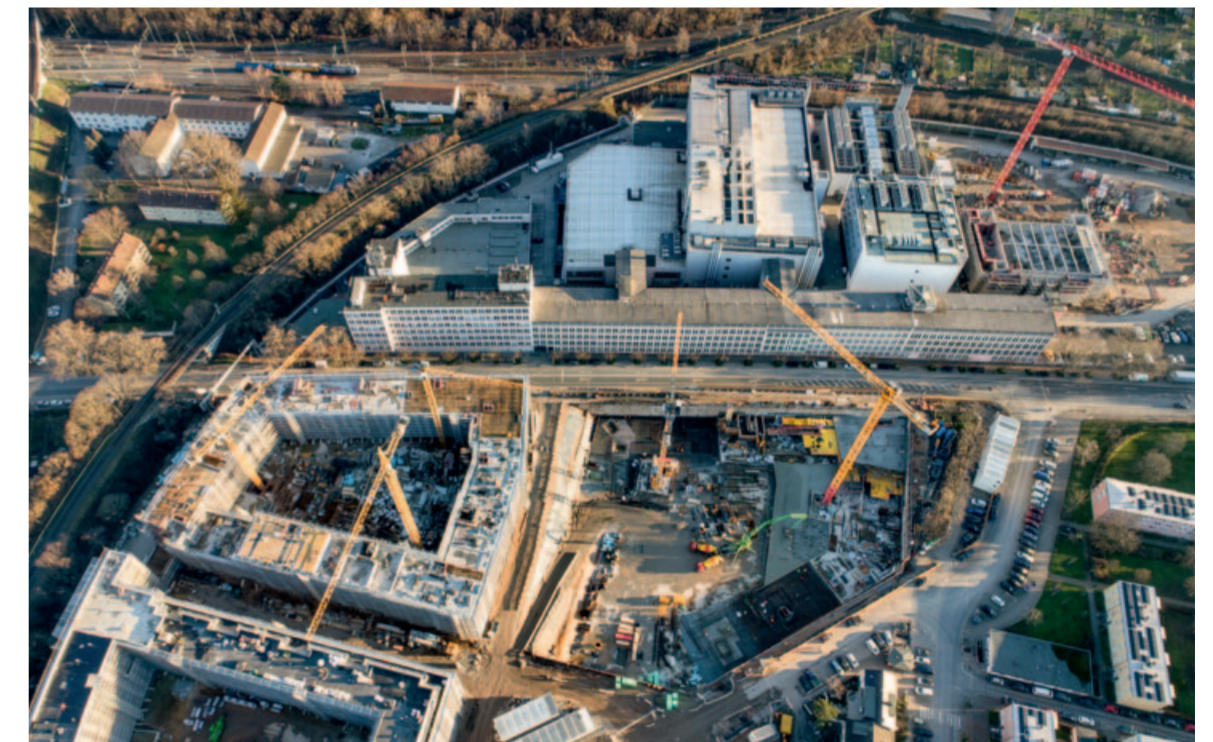
96.500 m 2 Wohnraum entstehen. Die geschlossene Struktur unterstreicht den Quartierscharakter und schirmt die Wohnungen nach innen von Lärm- und Luftverschmutzung ab. Oben im Bild das Rechenzentrum, von dem aus das Quartier mit Wärme versorgt werden wird.
