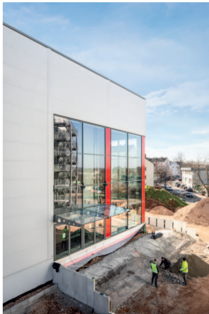
Die Halle erhielt eine 9,30 m hohe, filigrane Pfosten-Riegel-Fassade. Diese wurde trotz des Glasvordachs von 2,50 x 5,00 m ohne Zwischenstützen montiert.
