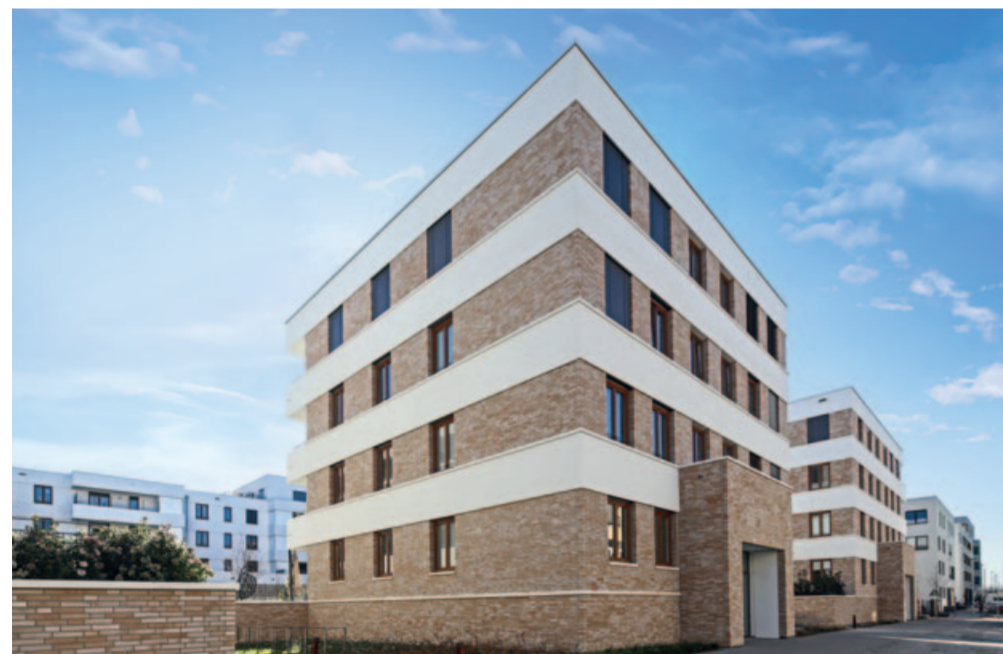
Wesentliches Gestaltungsmerkmal sind weiß umlaufende Bänder in Strukturputz, die zusammen mit der Klinkerfassade die Wertigkeit der Gebäude unterstreichen
