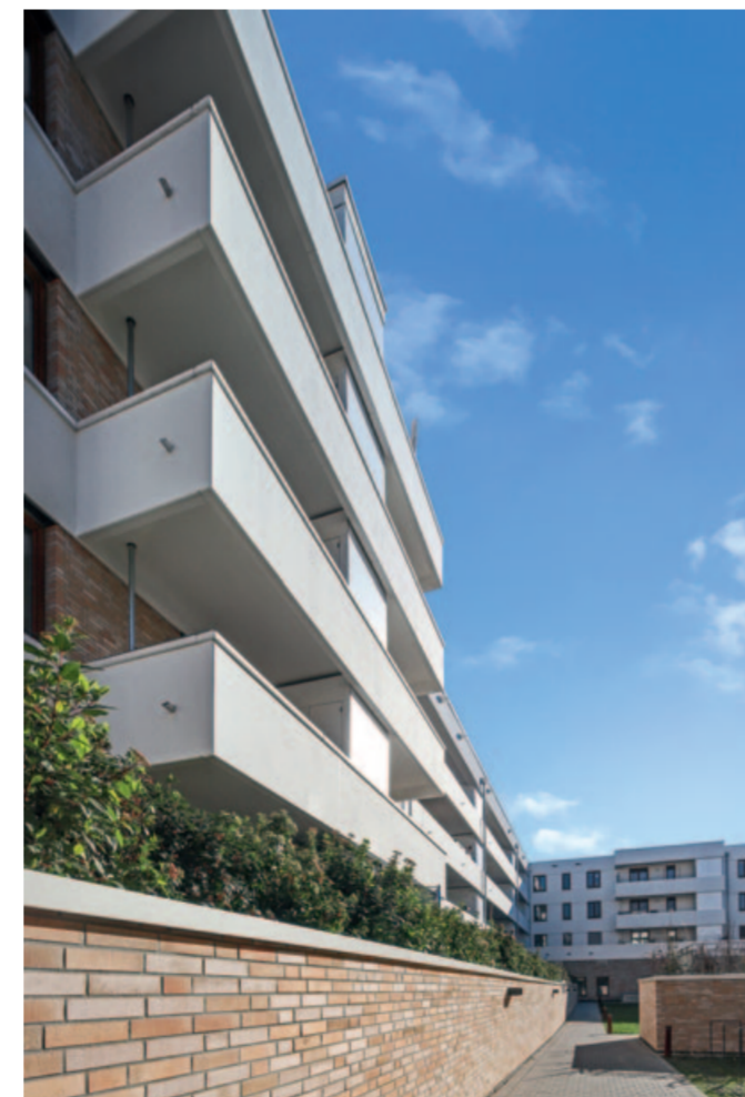
Die Balkone aus Betonfertigteilen führen die Akzentuierung durch die Gesimsbänder fort
