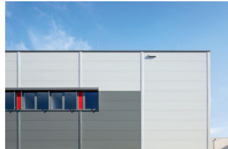
Hochwertiger Hallenlook: Die Isopanel-Fassade in Weiß wird aufgelockert mit grauen Flächen und einem Band aus Oberlichtern
