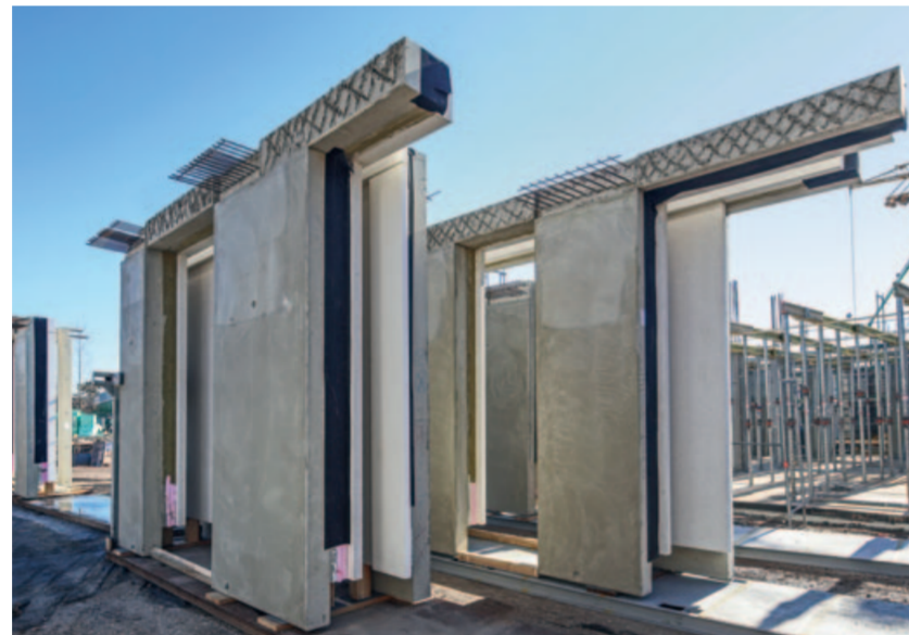
Die schlanken Sandwichelemente aus Architekturbeton weisen besonders empfindliche scharfe Kanten auf
