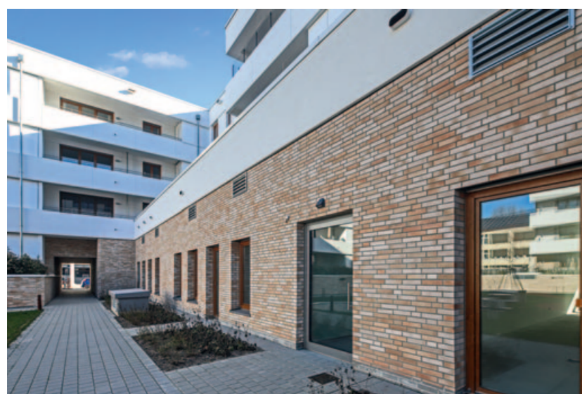
Die Fassade mit den umlaufenden Dekorprofilen und den warmen Klinkerflächen war Teil eines architektonischen Wettbewerbs
